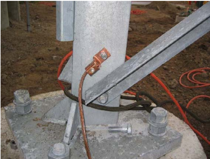
Figure 5.2: Tour avec un gros conducteur de terre en cuivre.
