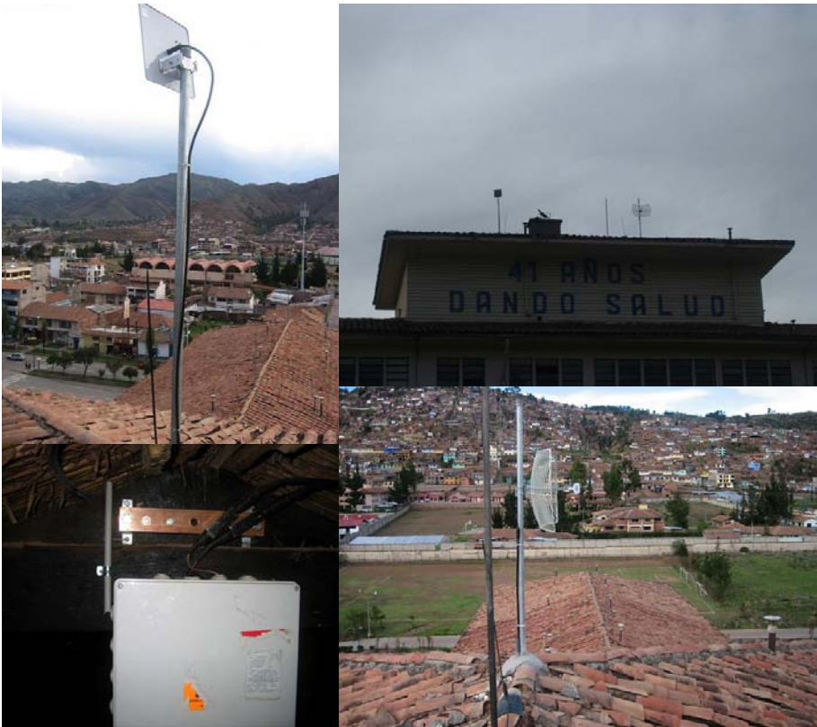
HOSPITAL CUSCO. De izquierda a derecha y arriba abajo: Antena directiva de 19dBi apuntando a la Red Sur, Antenas montadas en tejado, Caja de equipos montada en el interior del tejado y antena directiva de 24dBi apuntada al repetidor Josjojahuarina 1.
