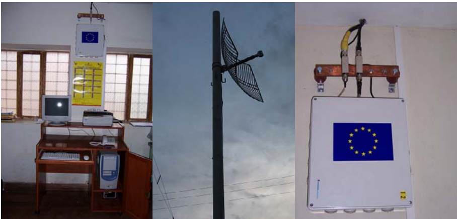
ACOPIA. De izquierda a derecha: Estación de cómputo y caja de equipo de telecomunicaciones, Antena de 24dBi montada en poste de 6 metros y Caja de equipo de telecomunicaciones.
