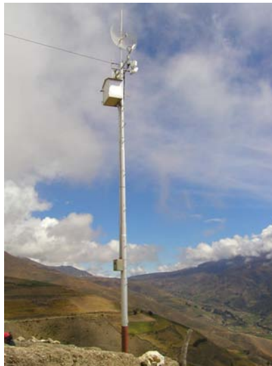
Figura 7.3: Una torre autoportada sencilla.
