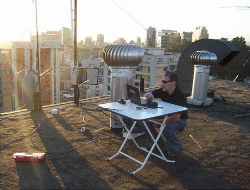
Nodo zona centro enlazado con nodo zona sur en Santiago, puede observarse antena parabólica que realiza el enlace y antena ranurada para captar clientes.
