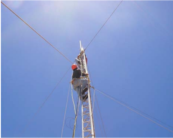
Figura 7.2: Una torre venteada escalable.
