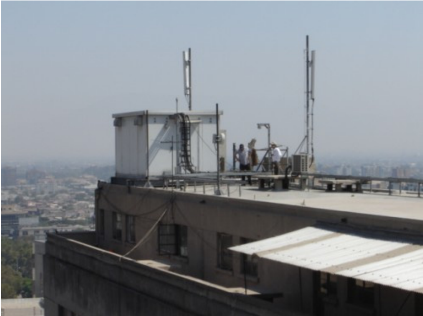
Instalaciones donde se encontraba la antena panel a la cual se enlazaba la parabólica (corresponde al lugar marcado por el círculo).
