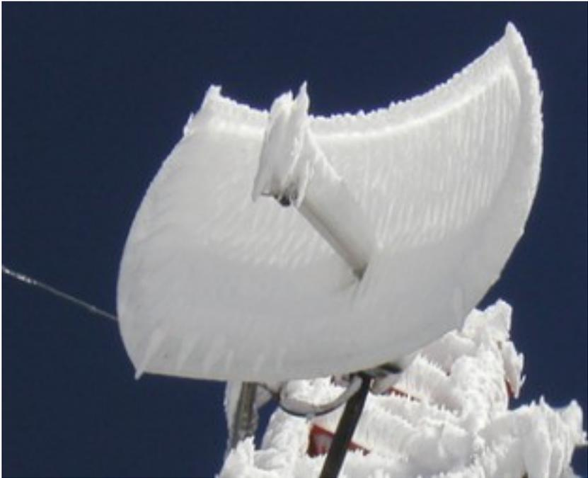
*Figure ATL 17: L'effet de la glace sur une antenne grille parabolique*
