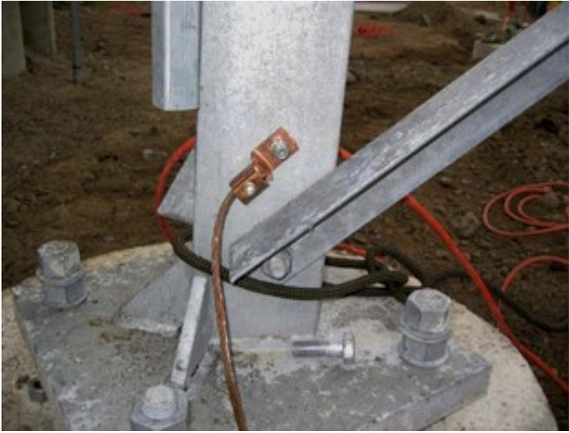
*Figure HW 3: Tour avec un gros conducteur de terre en cuivre.*
