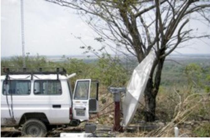
*Figure CsLD 9: Installation d'antenne à El Bau. L'altitude réelle était de 1° vers le haut car l'antenne avait un décalage de 22,5°.*
