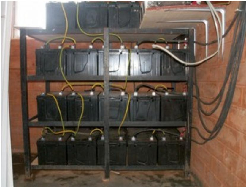
*Figure OGP 9: Un banc de batteries à 3600Ah avec des courants atteignant des niveaux de 45 pendant la charge*
